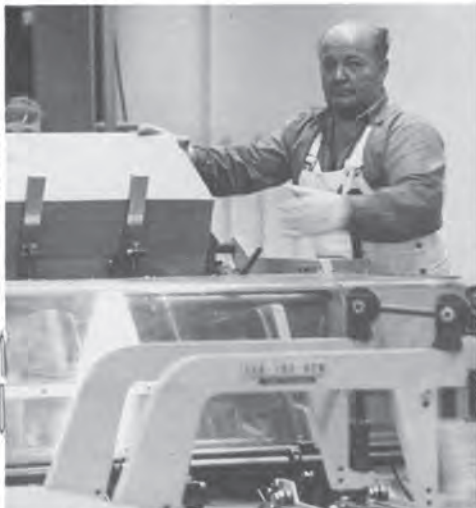
Vid Jagenberg-maskinen står "VICKE" (i kyrkboken står han för Erland Fernlund) och matar in plana kapselark för vikning och sidolimning.
